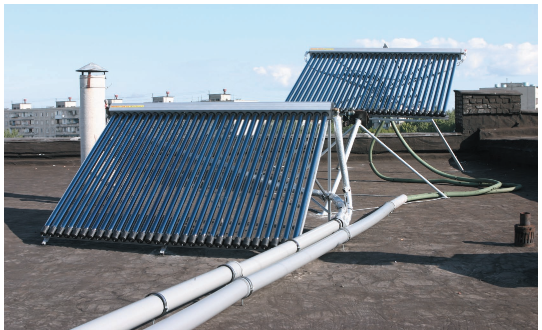
Рис. 1. Экспериментальная гелиосистема, созданная лабораторией инновационных технологий УкрГГРИ
