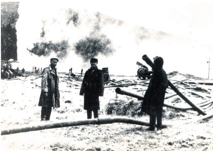
Івано-Франківська експедиція. Вибухові роботи з приборкування фонтана
