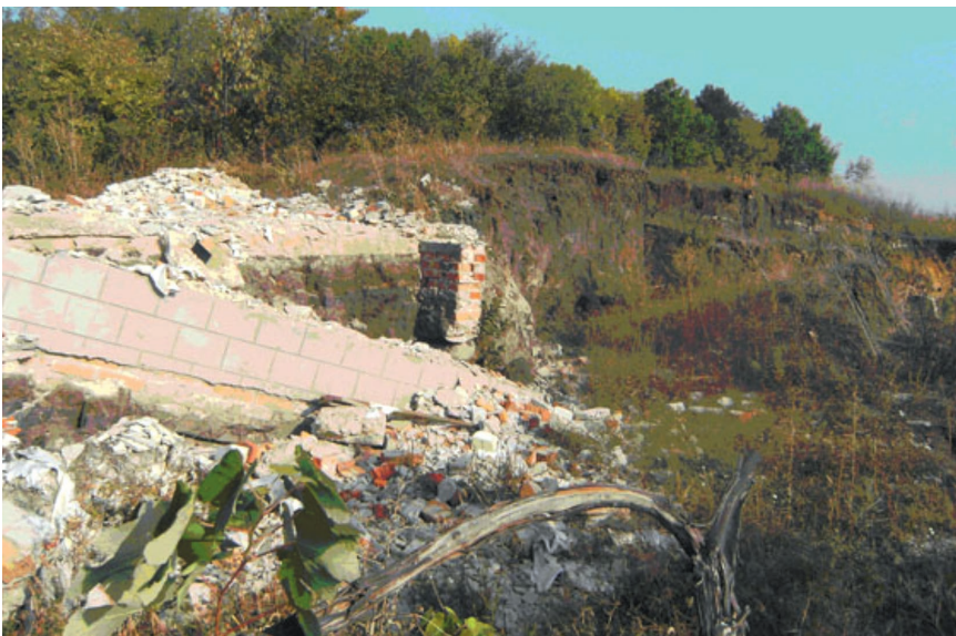
Рис. 2. Зсувом зруйнований садовий будиночок (м. Куп'янськ, вул. Мічуріна)
