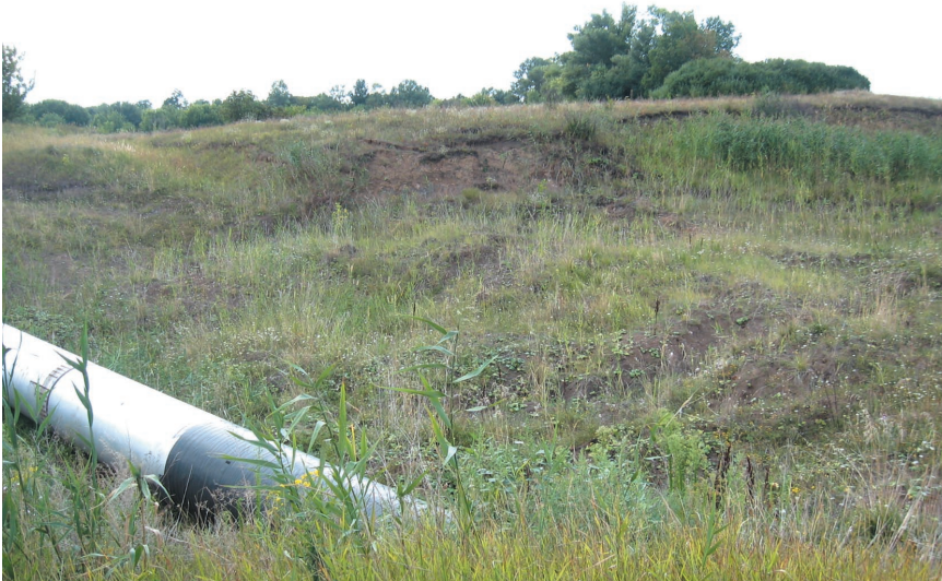
Рис. 3. Красноградський район, 1 533 км газопроводу "Союз". Труби газопроводу проходять через язик зсуву
