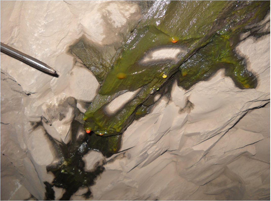
Фото 7. Просочення рідких вуглеводнів у породах Кросненської зони. Новий Бескидський тунель
