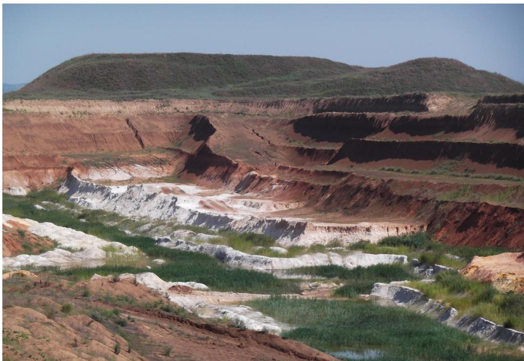
**Фото 6. Размыв и оползание уступов Северо-Западного карьера Торецкого месторождения в период временной приостановки работ**
