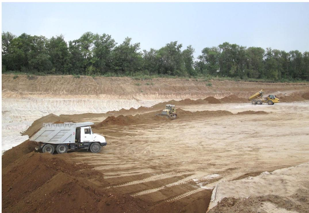
**Фото 7. Рекультивация отработанной части карьера Опытного месторождения с укладкой вскрышных пород в природной последовательности**
