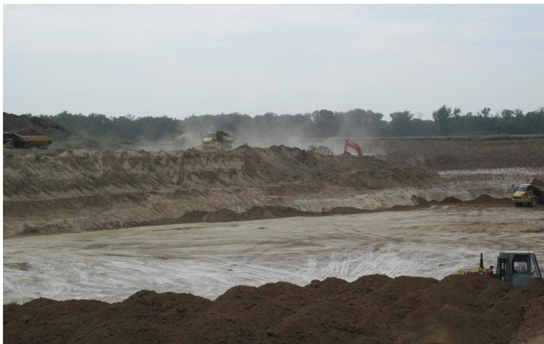
**Фото 10.** Запыление воздушного бассейна при экскавации вскрышных пород Опытного месторождения
