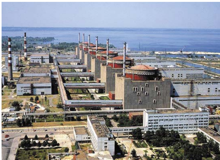
Фото 1. Запорізька атомна електростанція – найпотужніша в Європі
