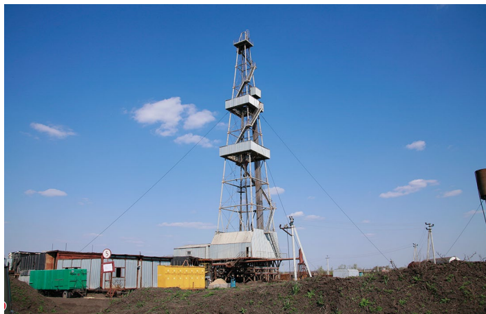
Фото 1. Бурова установка “Уралмаш 3Д”
